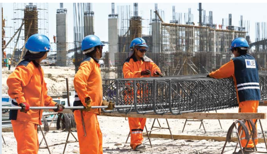
Trabajadores de la construcción verificando el armado de un elemento estructural.
