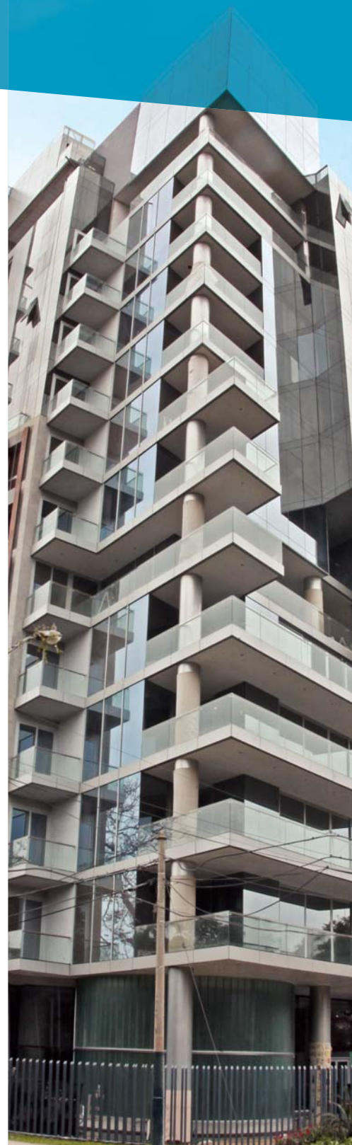
Edificio Multifamiliar Pezet - San Isidro (Lima). Construido con 500 TM de Acero Dimensionado®.
