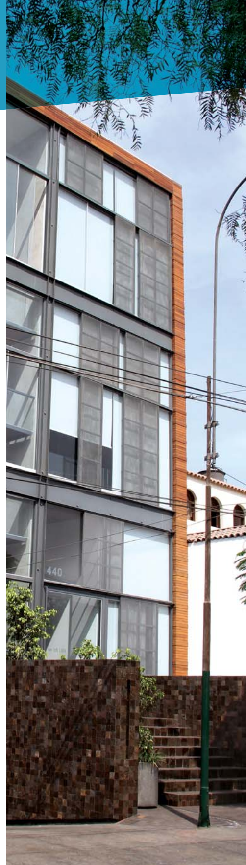
Fachada de un edificio residencial de Casuarinas - Surco (Lima). Construido con Planchas Especiales.
