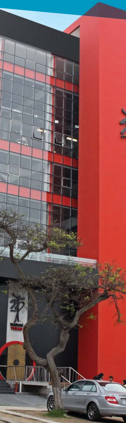
Edificio Santa Cruz - Miraflores (Lima). Construido con 174 TM de Acero Dimensionado®.
