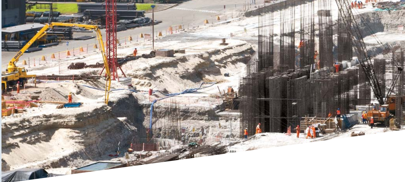
Vista de la construcción de la Línea de Laminación N°2 - Planta Pisco.
