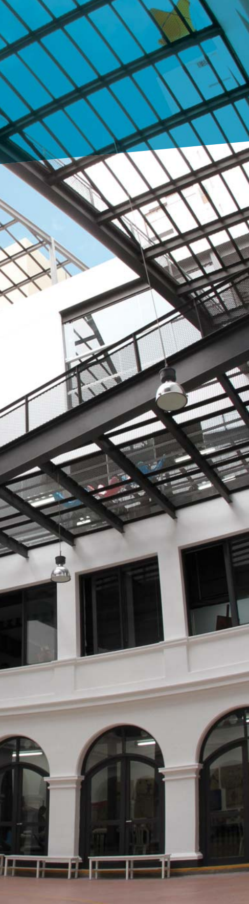
Ampliación de la Escuela de Arte Corriente Alterna - Miraflores (Lima). Realizada con Planchas Especiales.
