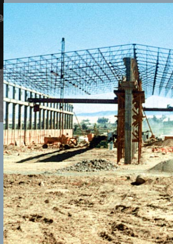
CONSTRUCCIÓN de la Nave de la PLANTA de laminación - Pisco
