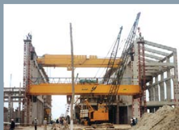
Montaje PLANTA de ACERÍA en Pisco
