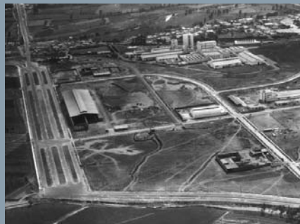
Vista Panorámica del Parque Industrial antes de la instalación de la Planta en Arequipa
