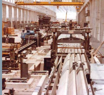
Montaje del Desbastador Pomini Farrell y las primeras cajas de laminación en Pisco
