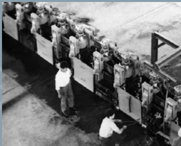
Cajas de laminación - Arequipa
