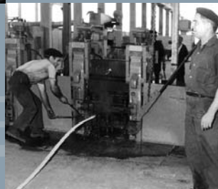
Antigua operación manual de guiado de las barras - Arequipa
