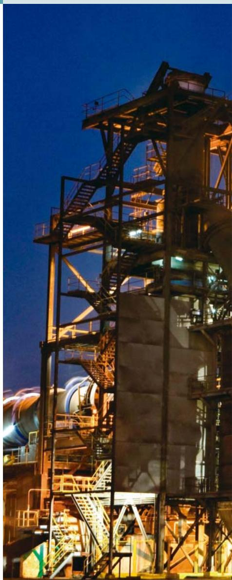
*Planta de Reducción Directa (Hierro Esponja), donde se reduce el mineral de hierro, que será usado en el horno eléctrico como carga metálica en la fabricación del acero.*
