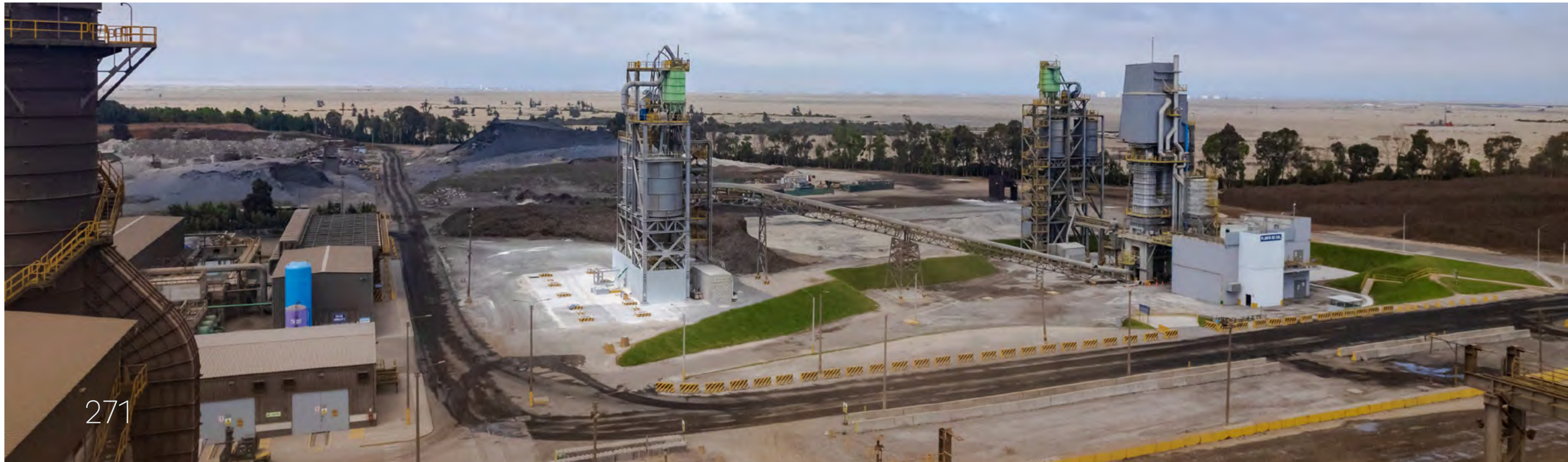
PLANTA DE CAL EN PISCO - ICA.
