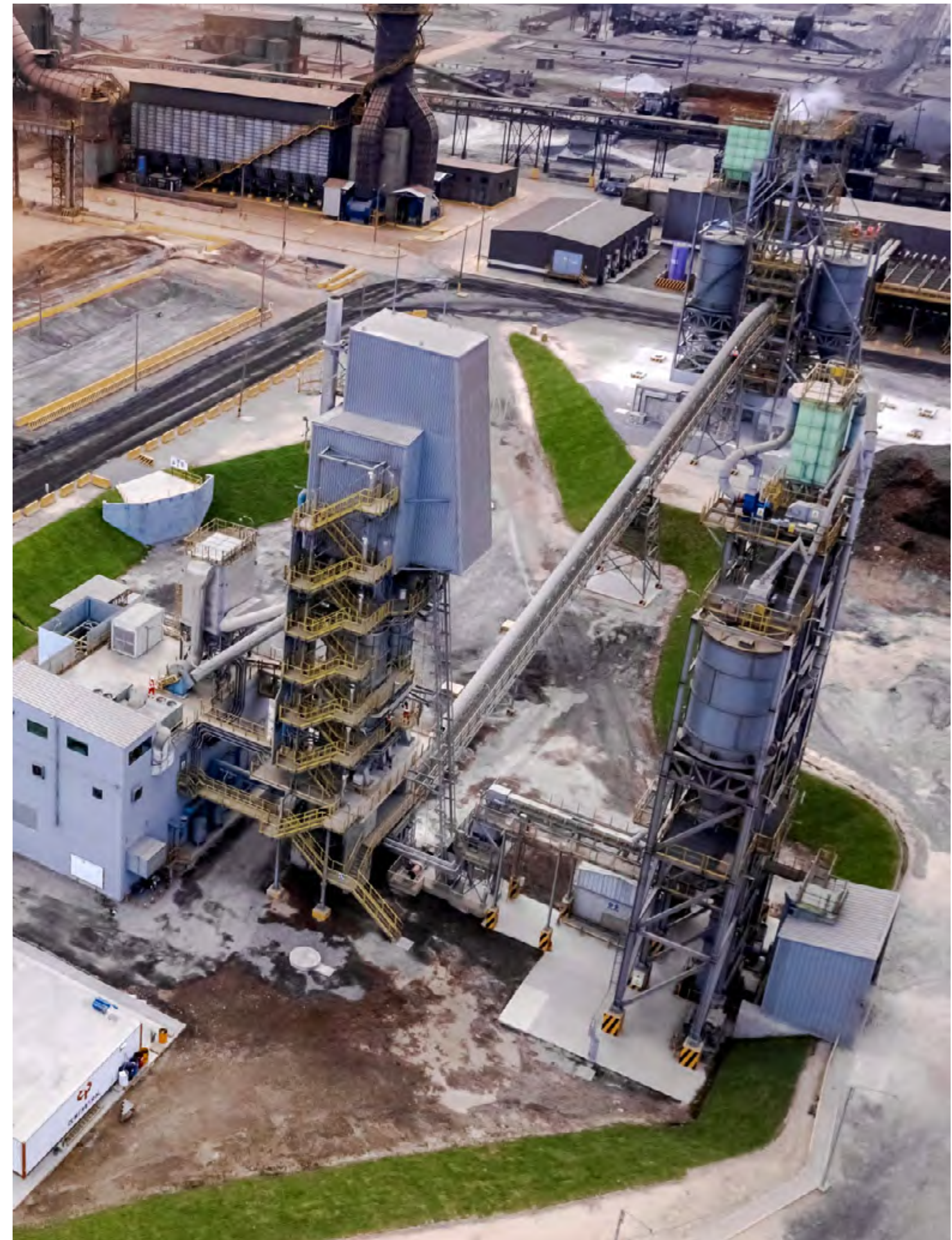
PLANTA DE CAL EN PISCO - ICA
