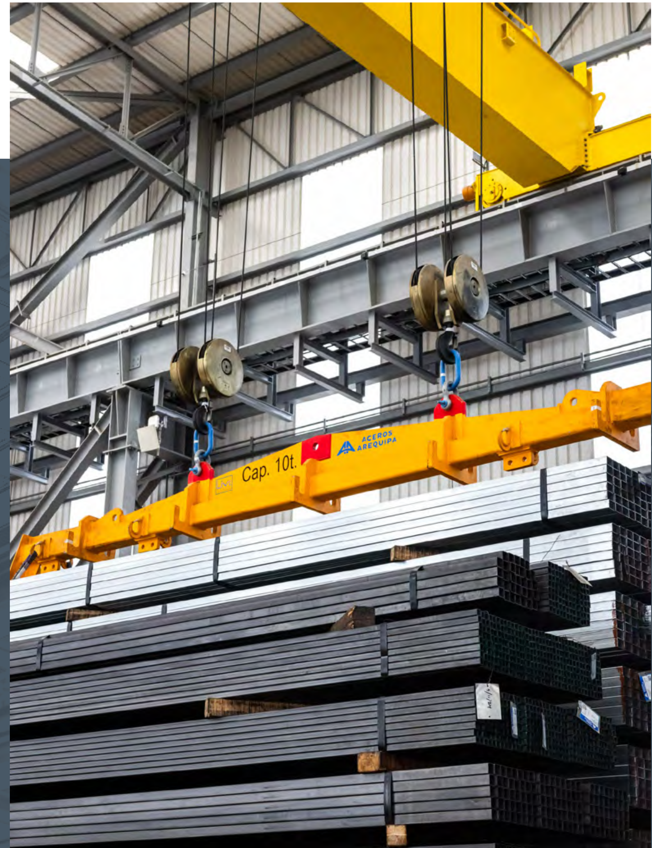
CENTRO DE DISTRIBUCIÓN LURIN
