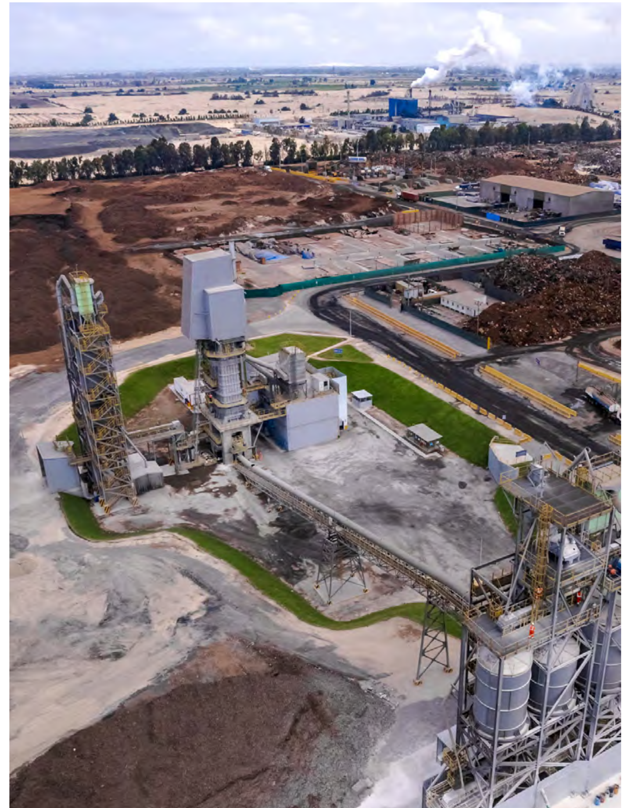
PLANTA DE CAL EN PISCO-ICA
