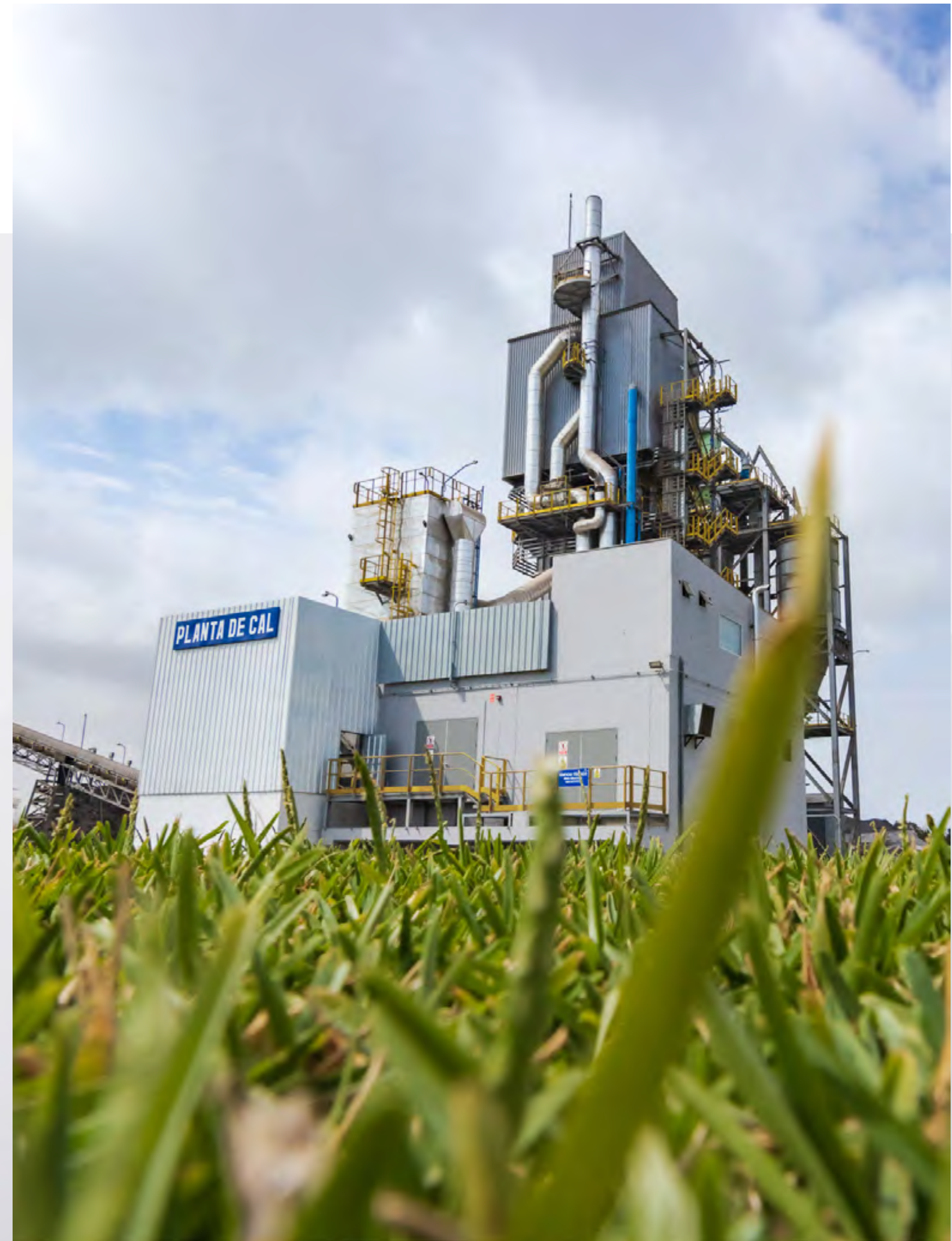
PLANTA DE CAL EN PISCO - ICA
