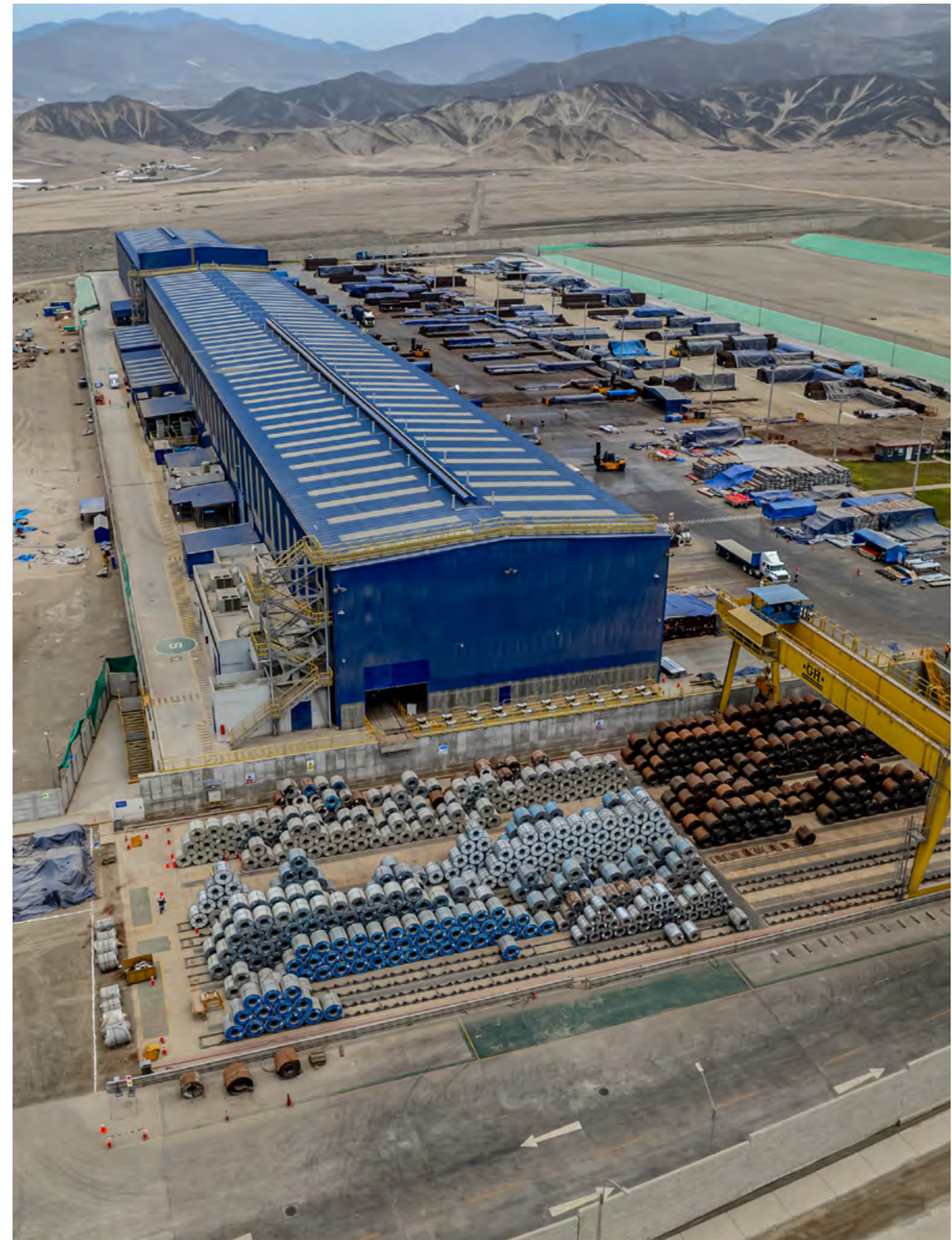
VISTA PANORÁMICA CENTRO DE DISTRIBUCIÓN LURÍN
