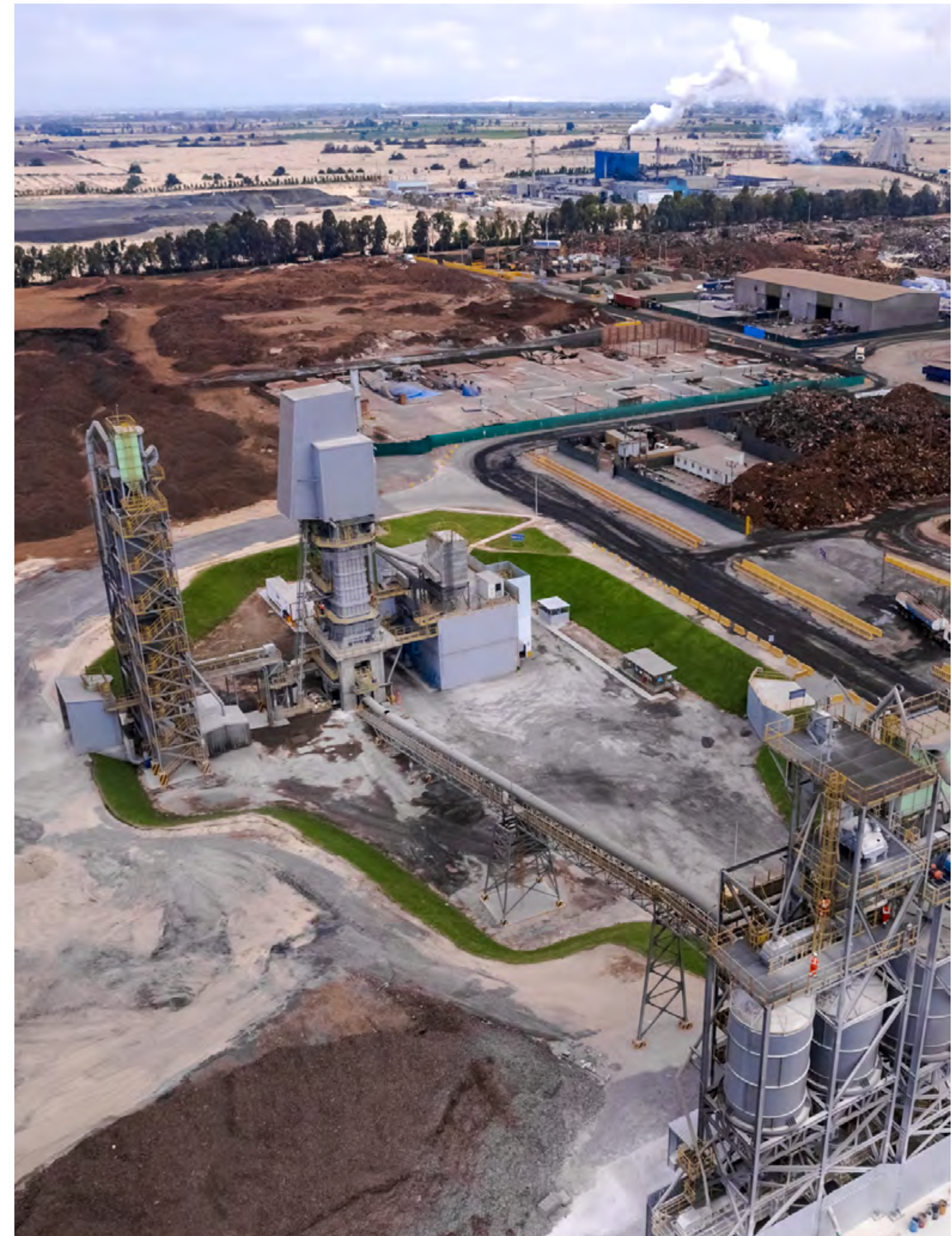
PLANTA DE CAL EN PISCO-ICA
